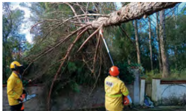
▲ Treballs de retirada d'arbres pels episodis de vent
